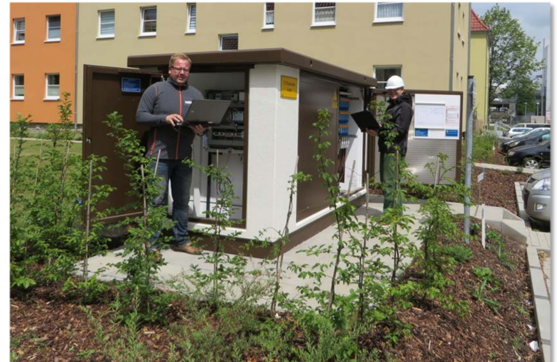
Inbetriebnahme einer intelligenten Trafostation
