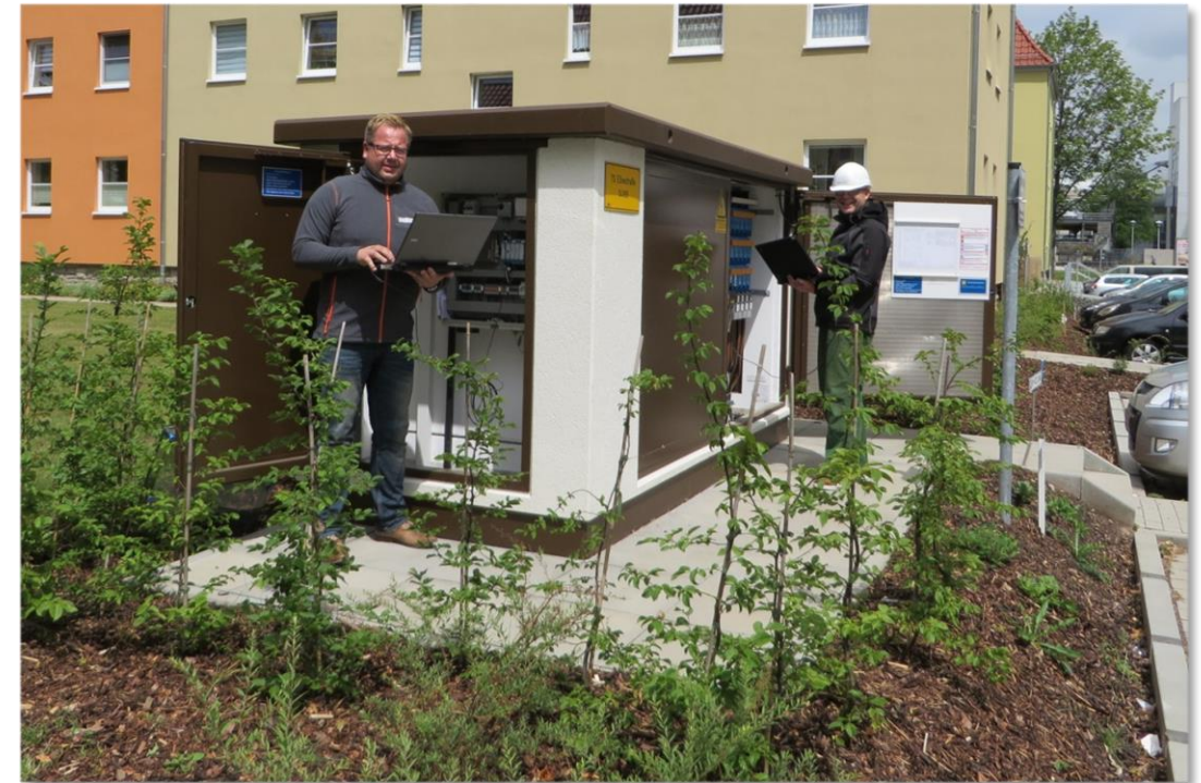
Inbetriebnahme einer intelligenten Trafostation
